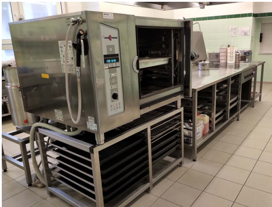
REFERENCE / Školní jídelna Čeladná – výdej 300 obědů denně
